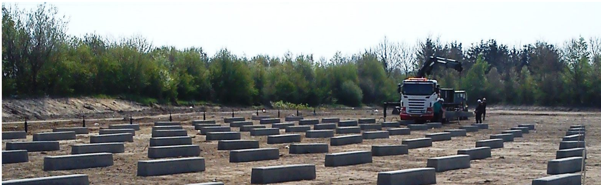
Opstilling af betonfundamenter ovenpå jorden
