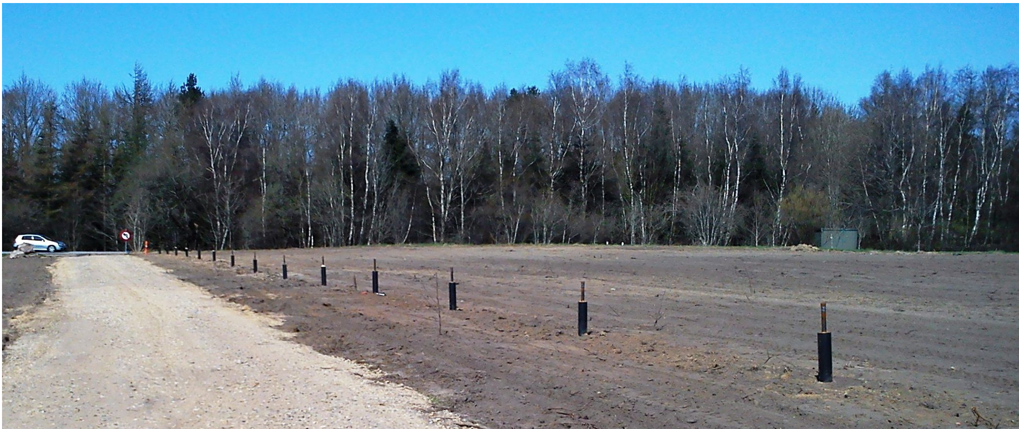
Servicevej langs fjernvarmerørene i det planerede område.
