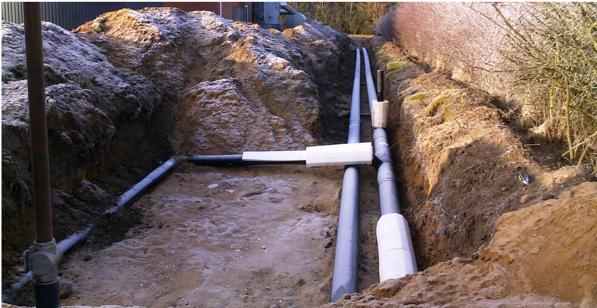
Indføring af fjernvarmerør på kraftvarmeværket
